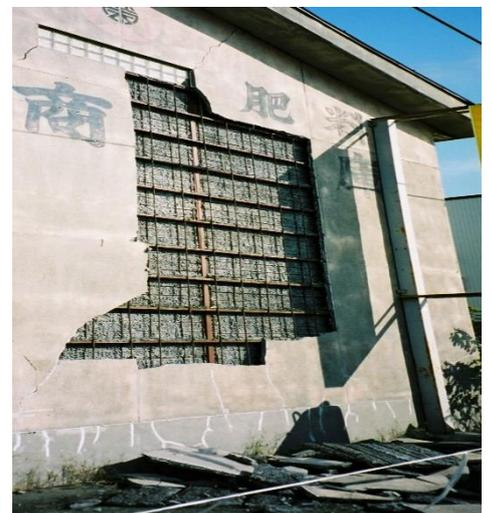
リブラスの腐食によるラスモルタルの脱落となった事例である。
