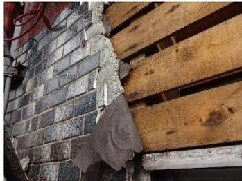
右下の写真は、倉庫の外壁である。リブラスを使用し、内外両面にモルタルが施工されていた。しかし、ラス下地としては丸棒鉄筋が使用され、ラスの留め付けになまし結束線が使用されており、全て防錆処理がされていないため、劣化による結束線、
